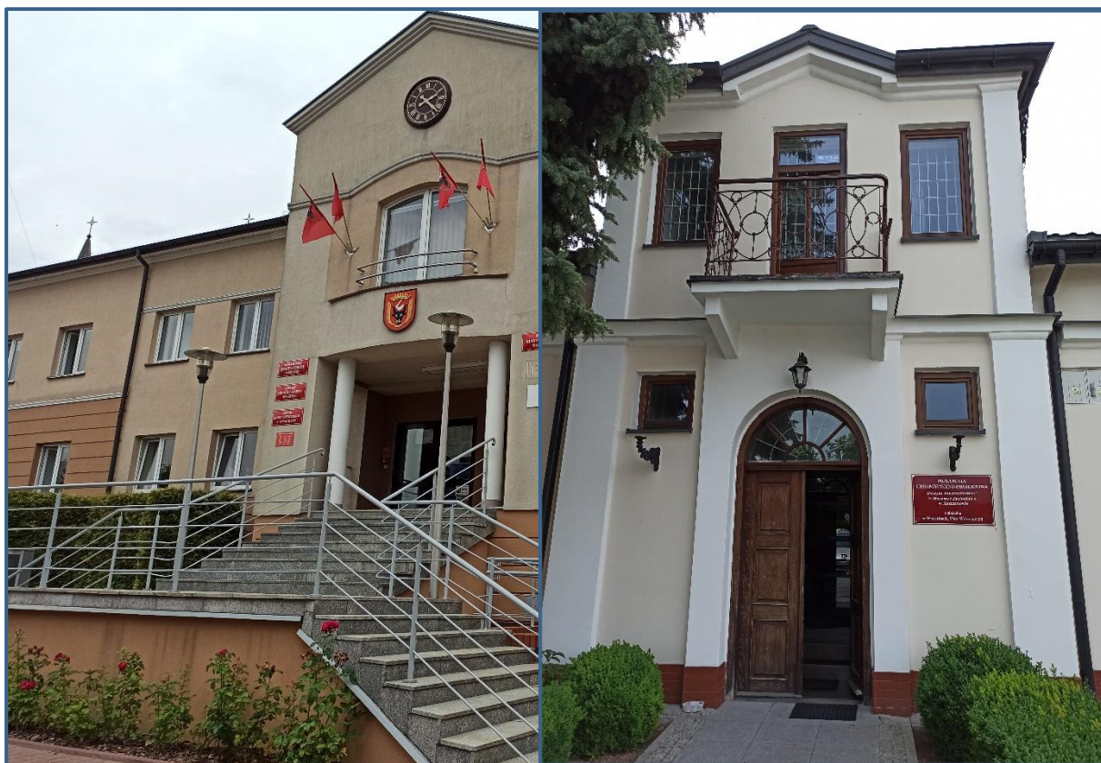
Ryc. 23. Budynki Urzędu Miasta i Gminy Wiskitki: Ul. Tadeusza Kościuszki 1 (po lewej), Plac Wolności 1A (po prawej)
