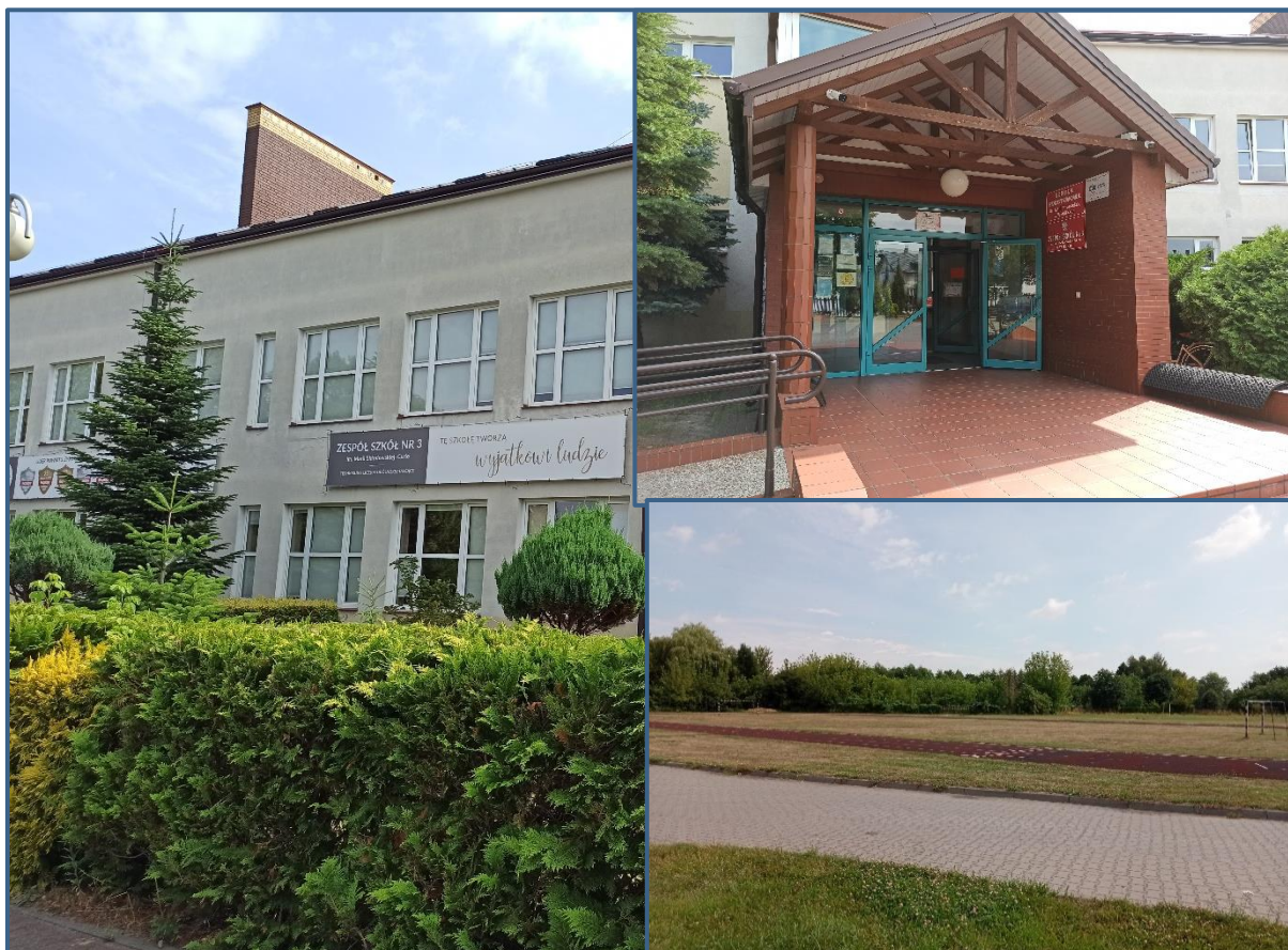
Ryc. 22. Stan techniczny budynku Szkoły Podstawowej oraz ZSP w Wiskitkach
